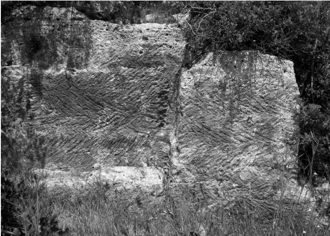
Εικ. 9. Λεπτομέρεια από μέτωπο εξόρυξης με ίχνη τύκου στον Αβλέμονα (Κύθηρα) (αρ. 238)
